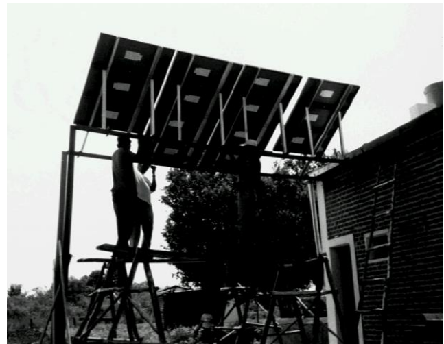
Fig. N° 5: Dos momentos en el Montaje de los Paneles
