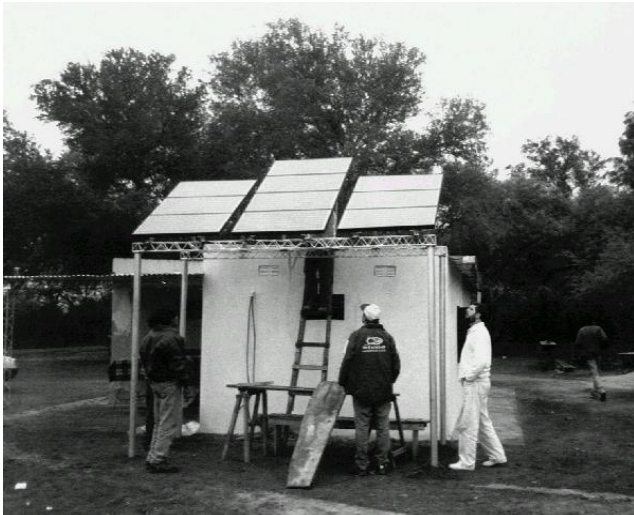
Fig. N° 3: Puesto Sanitario en Pampa del Infierno (Chaco)
